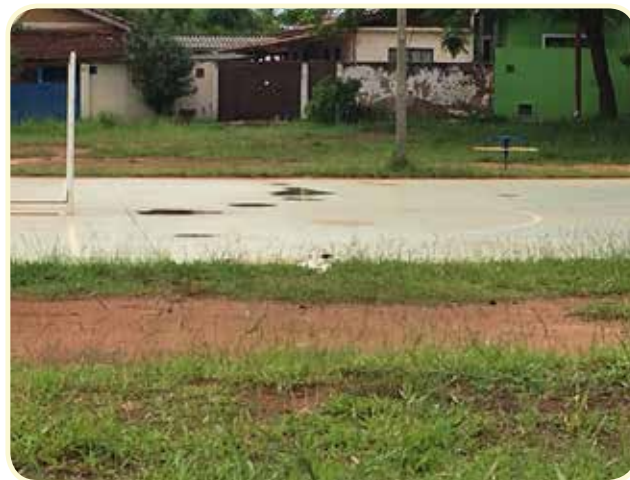
Construção da quadra no Jardim Paulista.
