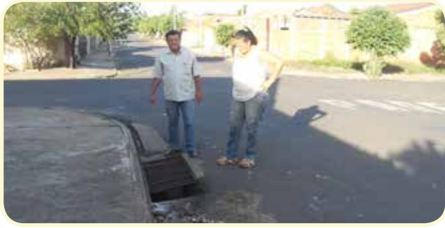
◀ Construção da Galeria Pluvial no bairro de Bom Viver
