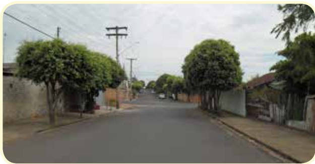
◀ Recape com asfaltamento no Jardim Bom Viver 3
